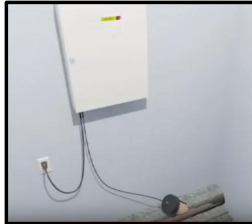
Le système pneumatique Aqua-Protect est un système qui fonctionne à l'aide d'un ballon gonflé par un compresseur lors d'un refoulement. Le ballon vient bloquer le passage de l'eau en période de refoulement et se dégonfle lorsque l'épisode de refoulement est terminé.
